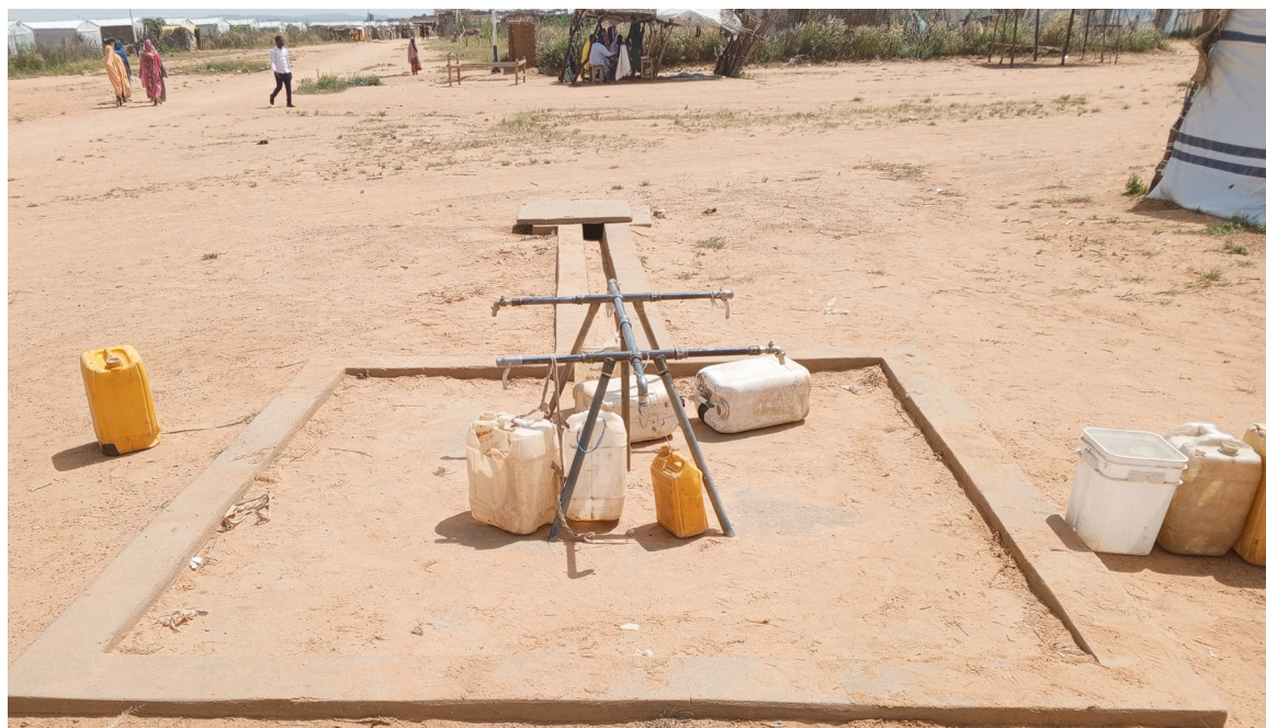
Photo 15: Robinets d'eau dans les sites de réfugiés de Farchana @ ONU-Habitat, 2025
